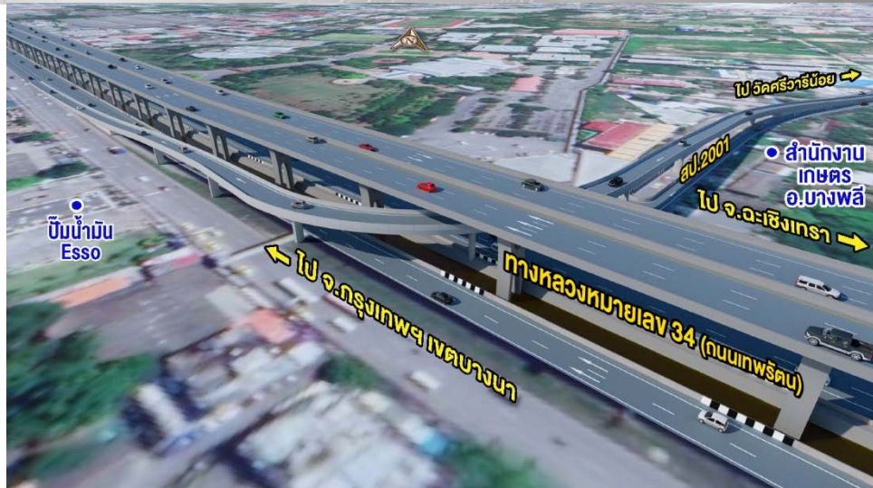
รูปที่ 8 ทางแยกต่างระดับจุดตัด ถ.วัดศรีวารีน้อย มุมมองด้านข้าง ทล.34 ฝั่งขาเข้ากรุงเทพฯ
