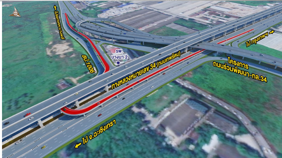
รูปที่ 12 ทางแยกต่างระดับจุดตัด ถ.เคหะบางพลี มุมมองไปทางถนนเคหะบางพลี
