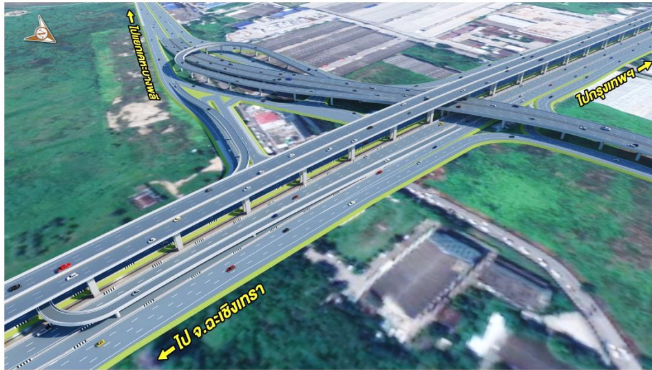
รูปที่ 7 ทางแยกต่างระดับจุดตัด ถ.เคหะบางพลี มุมมองไปทางถนนเคหะบางพลี
